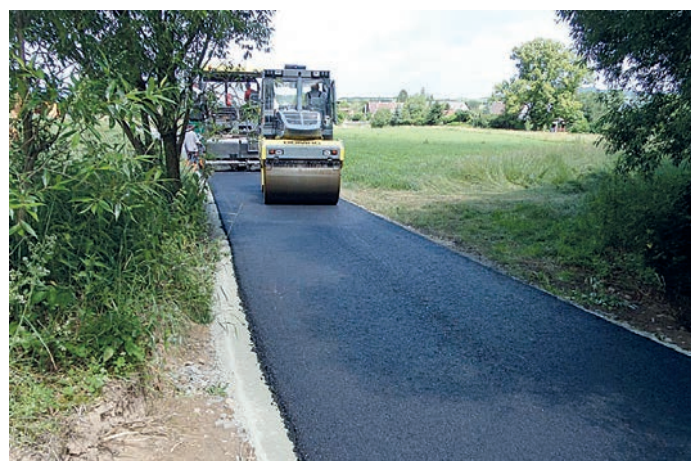
foto. droga gminna od drogi powiatowej nr 3231D
